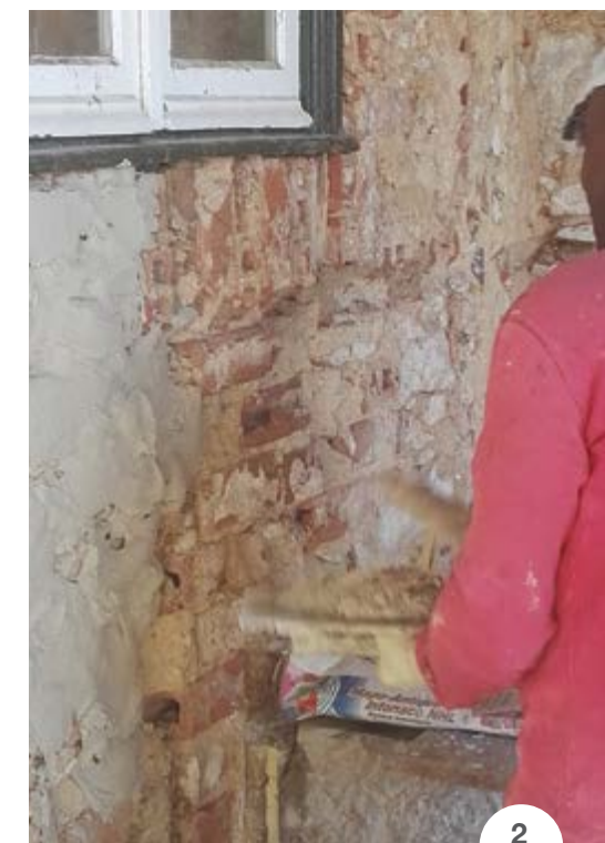
FOTO 1. Projeção de MAPE-ANTIQUÉ INTONACO NHL. FOTO 2. Afagamento de MAPE-ANTIQUÉ INTONACO NHL FOTO 3. Aplicação de MAPE-ANTIQUÉ FC CIVILE.
