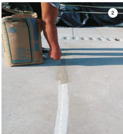
**SLIKA 1, 2:** Trajnoelastičnom poliuretanskom masom MAPEFLEX PU 45 FT zabrtvljene su dilatacije. Masa za brtvljenje je još svježija posuta kvarcnim pijeskom radi bolje prionjivosti narednog sloja.
