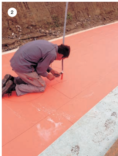
SLIKA 1: Položen polipropilenski geotekstil POLYDREN PP 300.
