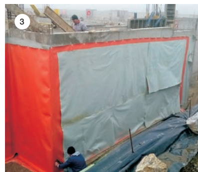
SLIKA 3: Polaganje sintetičke PVC-P folije MAPEPLAN UG na vertikalama zida.
