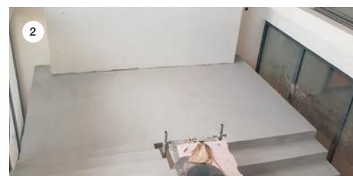
**SLIKA 1:** Reprofilacija većih oštećenja stubišta izvedena je reparaturnim mortom MAPEGROUT 430 razreda R3.
