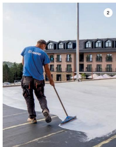
**SLIKA 1:** Lijepljenje gume podloge u rolama MAPECOMFORT R preko asfalta.
