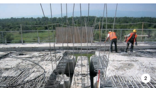
SLIKA 2: Priprema armature prije ugradnje sanacijskog betona/morta.
