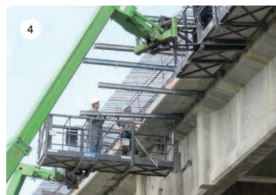
SLIKA 10: Površina mosta nakon ugradnje sanacijskog betona/morta.
