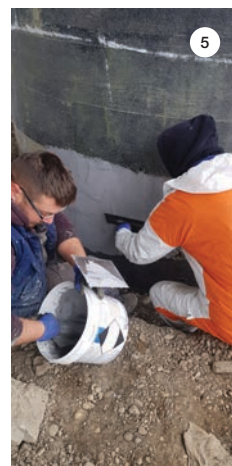
SLIKA 10: Površina mosta nakon ugradnje sanacijskog betona/morta.
