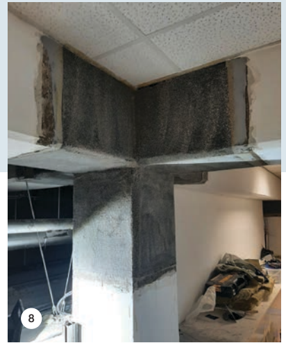
SLIKA 7: Nanošenje 2. sloja smole MAPEWRAP 31.
