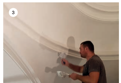
SLIKA 3: Površina je završno zaštićena vodoodbojnom paropropusnom bojom na silikonskoj osnovi – SILANCOLOR PAINT.
