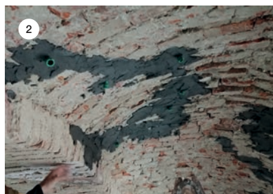
SLIKA 5: Crkva sv. Roka nakon konstrukcijske sanacije.
