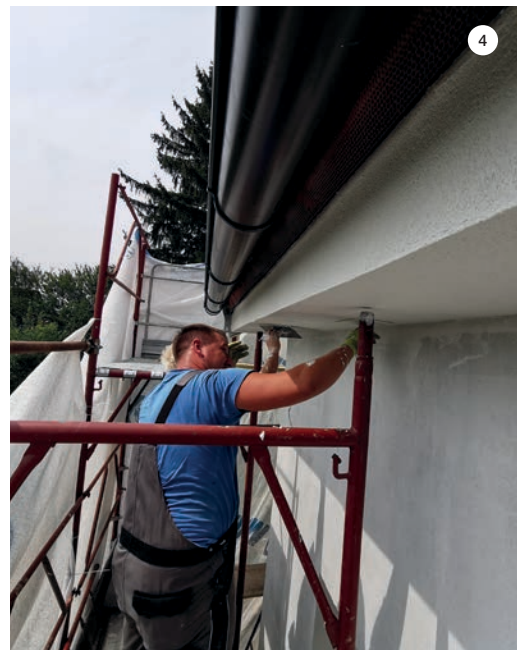
SLIKA 4 i 5: Nanošenje dekorativne žbuke QUARZOLITE TONACHINO.
