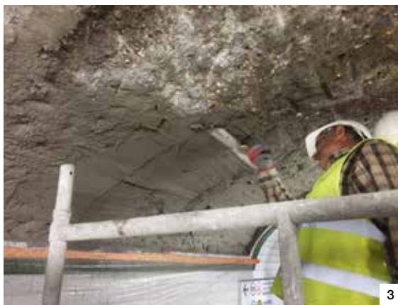
Photos 1, 2 et 3. Application du MAPEGROUT RESEAU 200 par projection sur la voûte maçonnée préalablement préparée.
