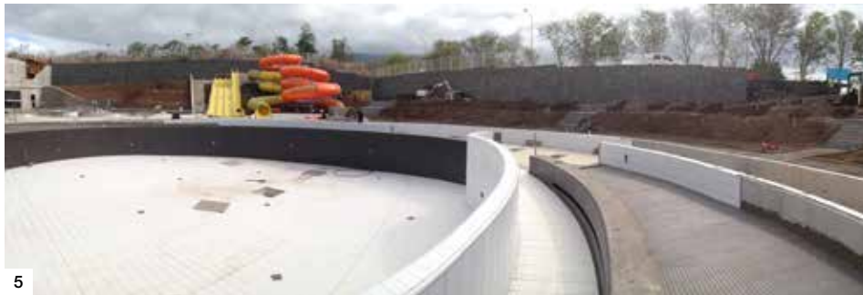
Photo 5. Les bassins et plages de piscine ont été imperméabilisés avec MAPELASTIC, le revêtement céramique a été collé avec KERAFLEX
