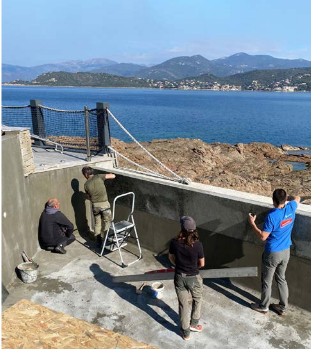
▲ Le collage de la feuille de pierre avec KERAPOXY EASY DESIGN : une mise en œuvre simple qui demande de la minutie.
