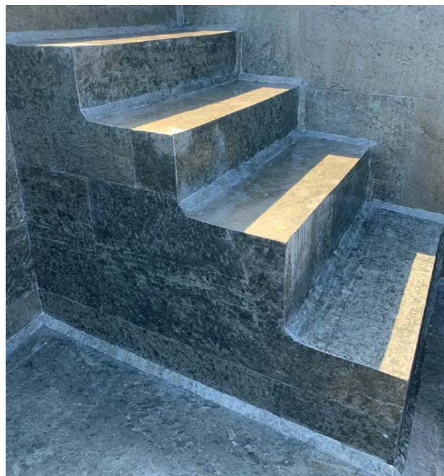
▲ Les 2 points techniques du chantier : le système à débordement et l'escalier.
