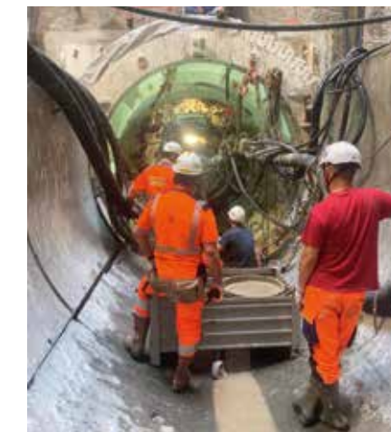
Le creusement du tunnel avec le tunnelier Ambre
