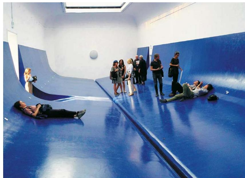
granulacije P120, usisan industrijskim usisivačima i potpuno otprašen. Drugi i završni sloj poda izveden je od dvo-komponentnog epoksidnog materijala za industrijske podove MAPEFLOOR I 300 SL, kojem je dodata pasta za toniranje MAPECOLOR PASTE (RAL 5002), a zbog tiksotropizacije materijala i postizanja protivkliznosti površine dodati su namenski materijali ADDITIX PE i
