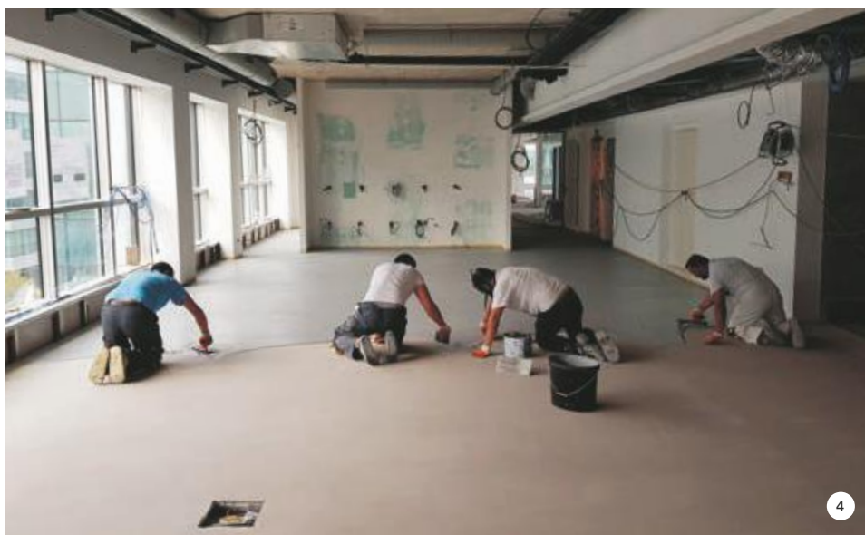
SLIKA 1: Stanje cementne košuljice pre početka ugradnje cementnog poda.
