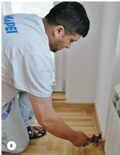
SLIKE 7 i 8: Lakiranje jednokomponentnim, 100 % poliuretanskim lakom na vodenoj bazi ULTRACOAT EASY.
