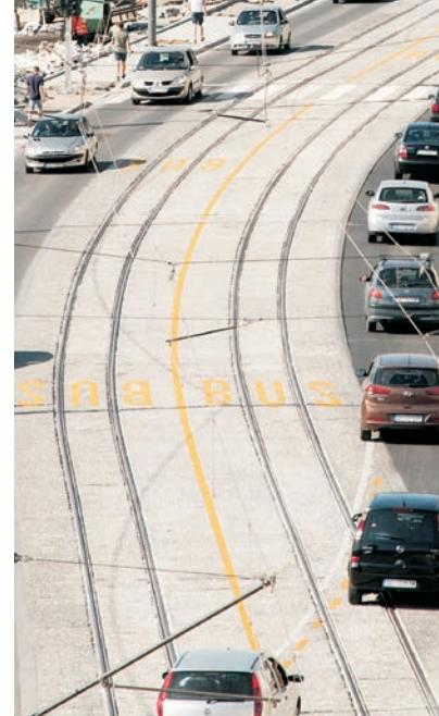
po prvi put, na nekoj od visokofrekventnih saobraćajnica u Srbiji polaganje zastora od kamenih kocki izvedeno na podložno-veznom sloju od tzv. gotovih maltera. Ukupna površina zastora od kamenih kocki je bila oko 2.300 m<sup>2</sup> na deonici dužine blizu 700 m.
