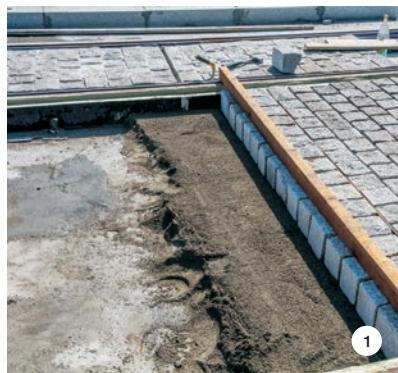
**SLIKA 1, 2 I 3:** Kamene kocke su polagane na sazrelu betonsku podlogu u sloju pripremljenog visokokvalitetnog maltera MAPESTONE TFB 60.
