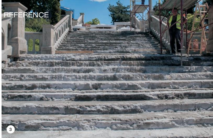
zamena gazišta monolitnim kamenim blokovima približnog izgleda i boljih svojstava, restauracija kamene ograde, potpornog zida i kamene figure lava. Izvedeni radovi su deo šireg projekta koji će obuhvatiti rekonstrukciju, konzervaciju i restauraciju dela Savskog šetališta od Velikog stepeništa ka ravelinu Kralj kapije. Radovi su izvedeni uz stalni stručni, konzervatorski i arheološki nadzor.
