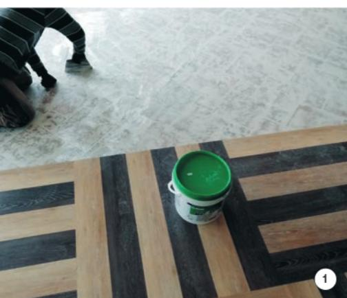
**SLIKA 1:** Pre ugradnje LVT ploča, celom površinom preko postojećih keramičkih pločica je naneta masa za izravnavanje i zaglađivanje PLANIPREP 4 LVT.
