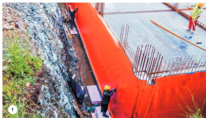
**SLIKA 1:** Hidroizolacija podzemnih delova konstrukcije izvedena je sintetičkom membranom na bazi PVC-a, MAPEPLAN UG 20.
