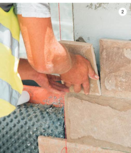
manje 2 mm, i ojačava umetanjem mrežice od alkalnootpornih staklenih vlakana MAPENET 150 u svež prvi sloj. Spojevi sa zidovima i dilatacije obrađeni su gumiranom MAPEBAND trakom. Nakon sušenja i sazrevanja hidroizolacionog sloja uspešno je izveden test vodonepropusnosti u trajanju od 72 h. Polaganje bazenske keramike je izvedeno lepkom KERAFLEX MAXI S1, klase C2TE S1, koji se može nanositi u debljini i do 15 mm. Fugovanje je obavljeno epoksidnom, kiselootpornom masom KERAPOXY CQ.
