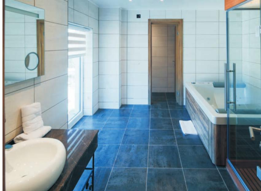
ULTRACOLOR PLUS, koja je ujedno otporna na pojavu budži (zahvaljujući tehnologiji Bioblock®) i iscvetavanje soli, a može se koristiti za fuge širine od 2 do 20 mm. Sve dilatacije i spojevi su obrađeni trajnoelastičnom acetatnom masom MAPESIL AC.
