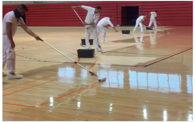
ARRIBA. A la izquierda, marcado de líneas y aplicación de ULTRACOAT SPORT COLOR y a la derecha, aplicación de ULTRACOAT HT SPORT en su última mano. ABAJO. Pavimento terminado
