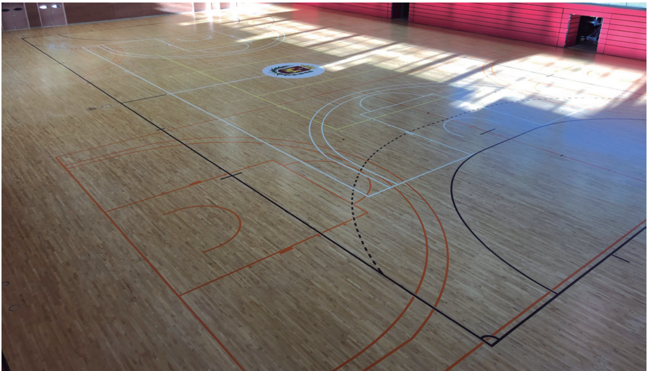
ARRIBA. A la izquierda, marcado de líneas y aplicación de ULTRACOAT SPORT COLOR y a la derecha, aplicación de ULTRACOAT HT SPORT en su última mano. ABAJO. Pavimento terminado
