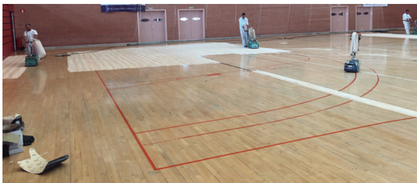
ARRIBA. Estado inicial del pavimento y su deterioro. ABAJO. Fase del trabajo para realizar el emplastecido y sellado de juntas y fisuras
