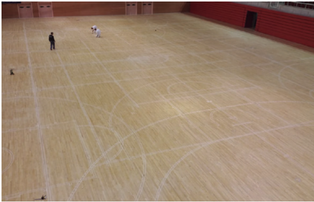
ARRIBA. A la izquierda, marcado de líneas y aplicación de ULTRACOAT SPORT COLOR y a la derecha, aplicación de ULTRACOAT HT SPORT en su última mano. ABAJO. Pavimento terminado
