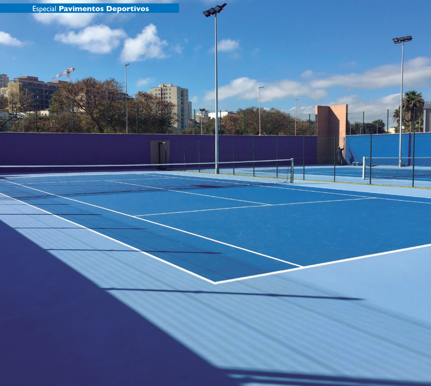
Vista de la superficie de las dos pistas tras la renovación con el sistema MAPECOAT TNS
