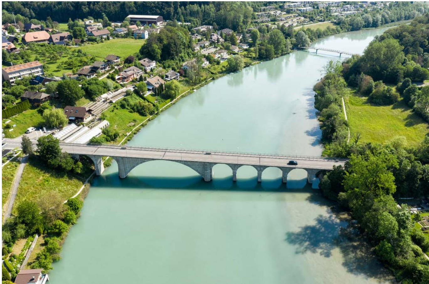
In der 100-jährigen Kappelenbrücke bei Wohlen hatten sich im Laufe der Zeit Risse unter dem Fahrbahnbelag gebildet – eine Totalsanierung war unumgänglich geworden. MAPEI unterstützte die Bauarbeiten mit ihren Betoninstandsetzungs- und Abdichtungsprodukten.
