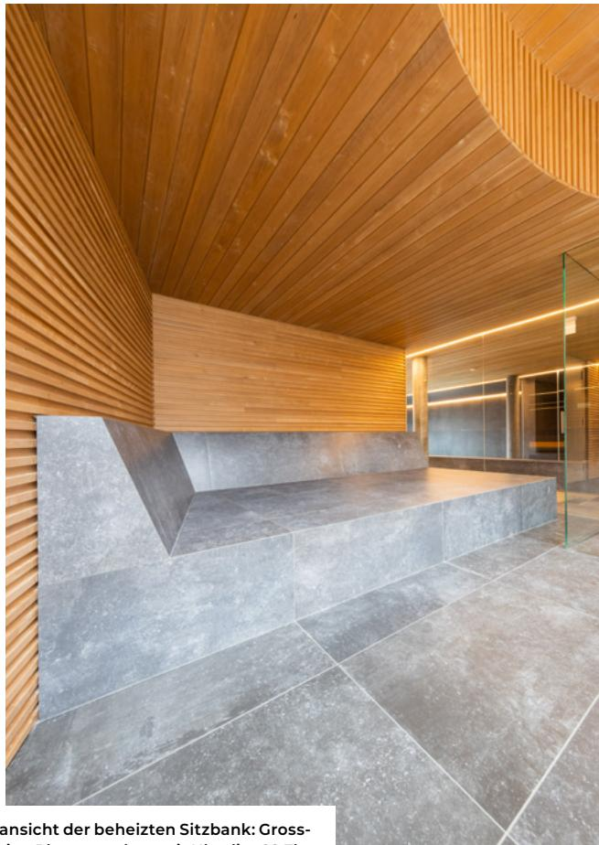
Detailansicht der beheizten Sitzbank: Grossformatige Platten verlegt mit Ultralite S2 Flex.
