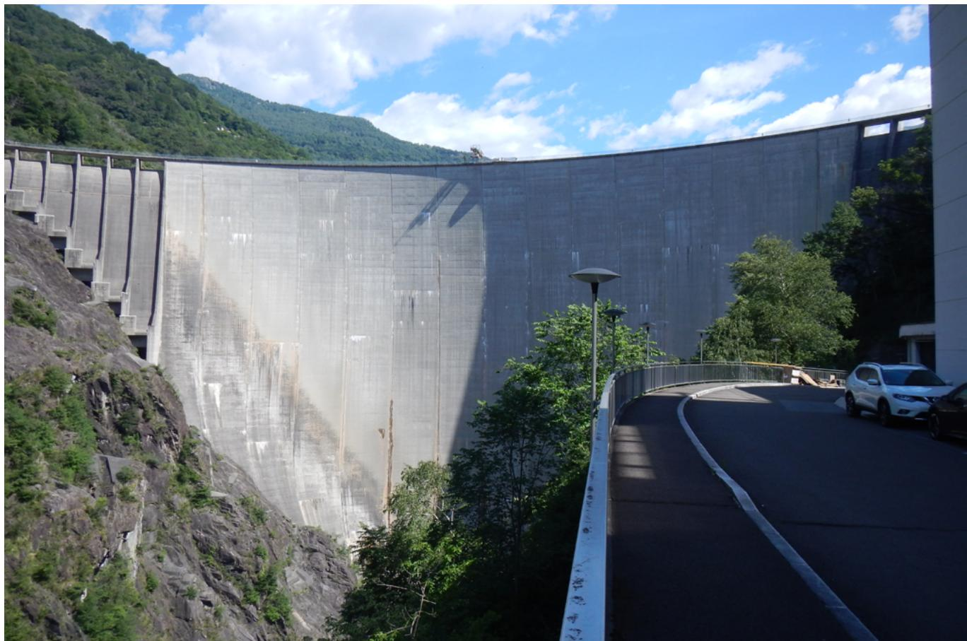
Die Sanierung der Staumauer im Verzascatal war längst überfällig. Die Bauherrschaft Verzasca SA hat den Stausee umgeleitet und das 5,5 Kilometer lange Seebecken fast vollständig ausgetrocknet, um die Arbeiten im Trocknen ausführen zu können. Bei der Sanierung haben die Bauprodukte von Mapei überzeugt.
