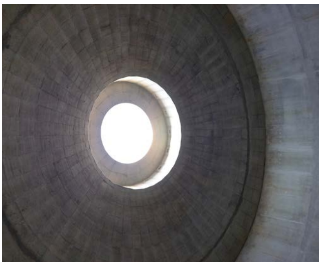
Innenansicht: obere Öffnung des Faulturms. Trou supérieure du digesteur vu de l'intérieur.
