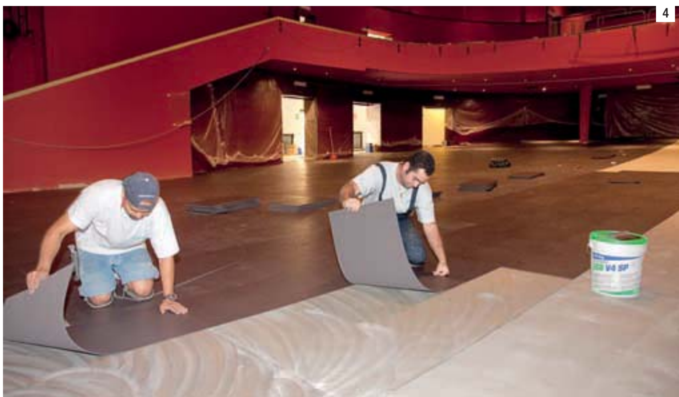
Foto 4. Per la posa dei teli in gomma è stato utilizzato l'adesivo a bassa emissione di sostanze organiche volatili (VOC) ULTRABOND ECO V4 SP.
