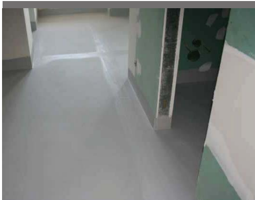
Foto 1 e 2 - Aplicação de Mapegum WPS nas casas de banho
