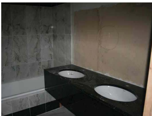
Foto 3 e 4 - Assentamento e betunação dos revestimentos das casas de banho com Adesilex P9 e Keracolor FF DE
