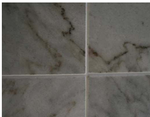
Foto 3 e 4 - Assentamento e betunação dos revestimentos das casas de banho com Adesilex P9 e Keracolor FF DE
