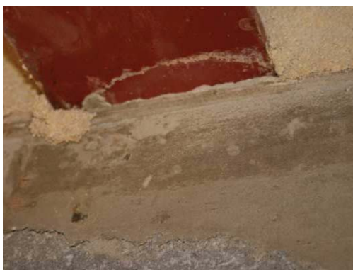
Foto 5 e 6 - Ancoragem de vigas de aço com Lam pocem
