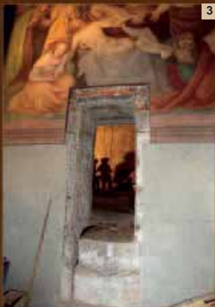
Foto 3. Abbattimento del muro che impediva il collegamento tra la torre e la cappella attigua.
