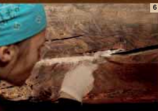
Foto 6. Stuccatura delle fessure presenti sulle travi con Ravemul 017 della Vinavil e segatura.
