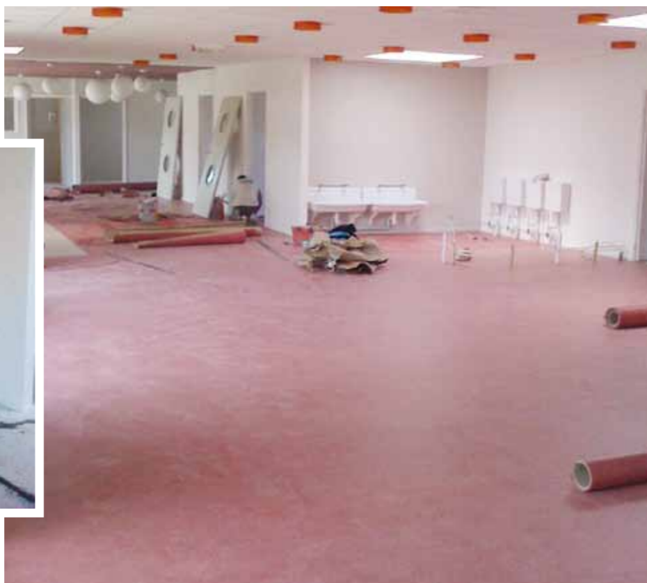
La pose du linoléum Marmoleum de Forbo
