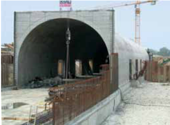
Tunnel in offener Bauweise (Bild Hankenfeld)
