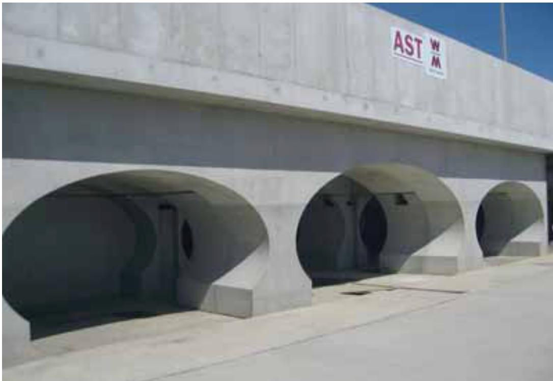
Tunnel in offener Bauweise (Bild Hankenfeld)
