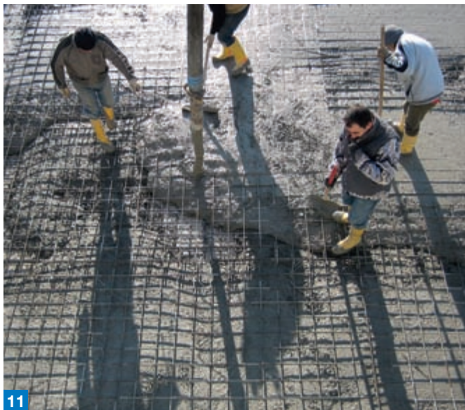
Foto 11. Particolari della fase di getto della platea di fondo canale.
