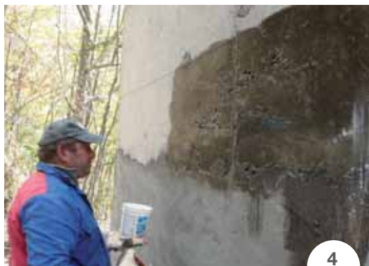
FOTO 4. L'applicazione del primer epossidico MAPEWRAP PRIMER 1.
