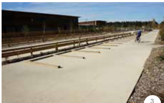
Photo 1 Mise en place du revêtement Hormigon teinté avec MAPECOLOR PIGMENT
