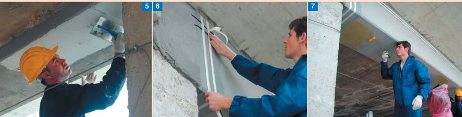
Foto 5. Applicazione dello stucco epossidico MapeWrap 11 per la regolarizzazione delle superfici in calcestruzzo da consolidare.
