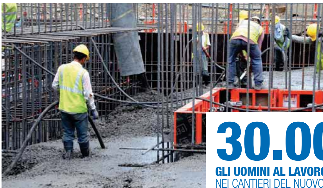
IN QUESTE FOTO FOTO. Per questo grandioso cantiere, Mapei ha sviluppato un additivo ad hoc, DYNAMON XP2 EVOLUTION 1, che ha dato ottimi risultati in termini di lavorabilità e di posa in opera del calcestruzzo.
