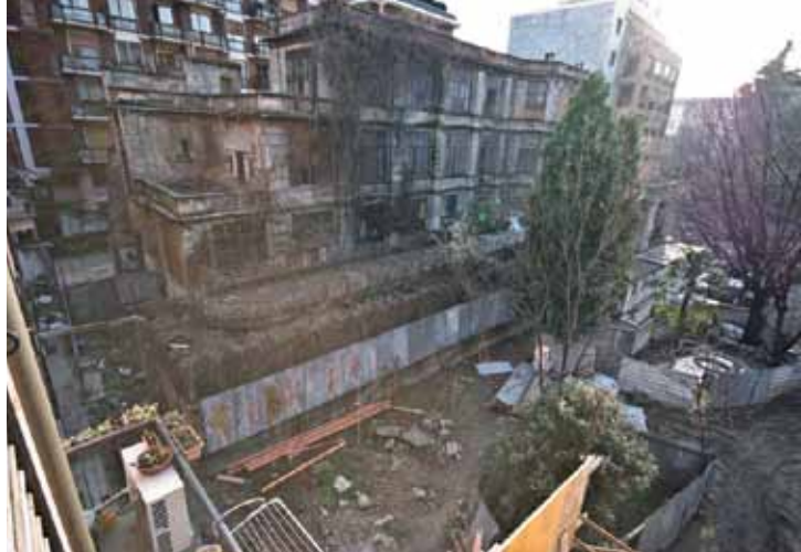
SOPRA. Ecco come appariva l'area di cantiere prima degli interventi.
