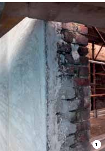
FOTO 1. Particolare dell'intonaco traspirante applicato ai piani superiori.
