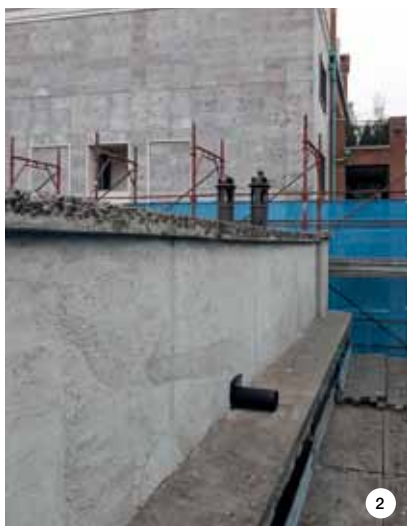
FOTO 1. Particolare dell'intonaco traspirante applicato ai piani superiori.
