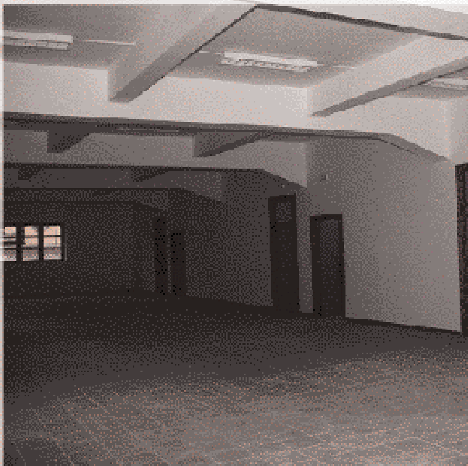
Foto 11. Applicazione sull'intradosso delle lamine CARBOPLATE, a interasse corrispondente alla nervatura del solaio.
