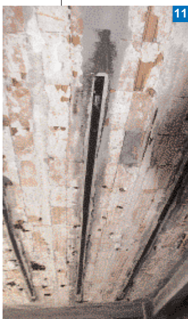
Foto 11. Applicazione sull'intradosso delle lamine CARBOPLATE, a interasse corrispondente alla nervatura del solaio.
