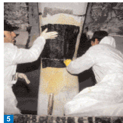
Foto 5. Dopo la preparazione delle superfici e del tessuto con resine epossidiche, si passa all'applicazione diretta del tessuto sulla struttura.
