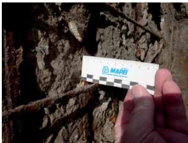
Degradacja betonu należącego do konstrukcji instalacji gaszenia żużla (strefa I).
