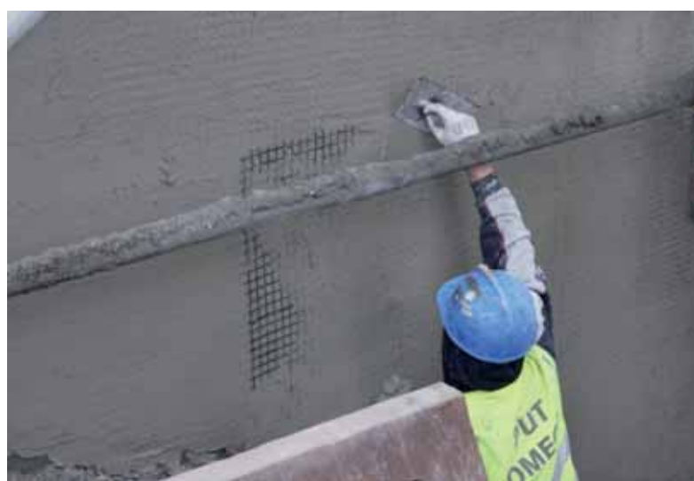
Wklejanie siatki MAPEGRID G220 w cementowo-polimerową zaprawę naprawczą PLANITOP HDM.
