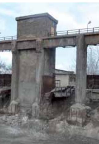
Degradacja betonu należącego do konstrukcji instalacji gaszenia żużla (strefa I).
