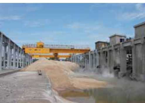
Wyremontowana konstrukcja strefy zrzutu żużla.
