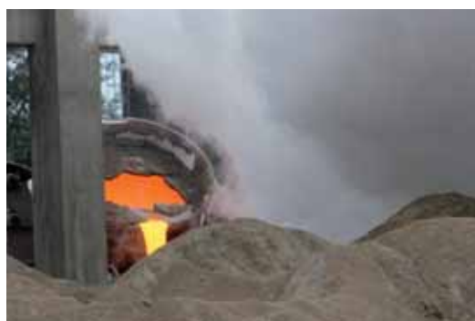
Eksplotacja instalacji w strefie zrzutu i gaszenia żużla.
