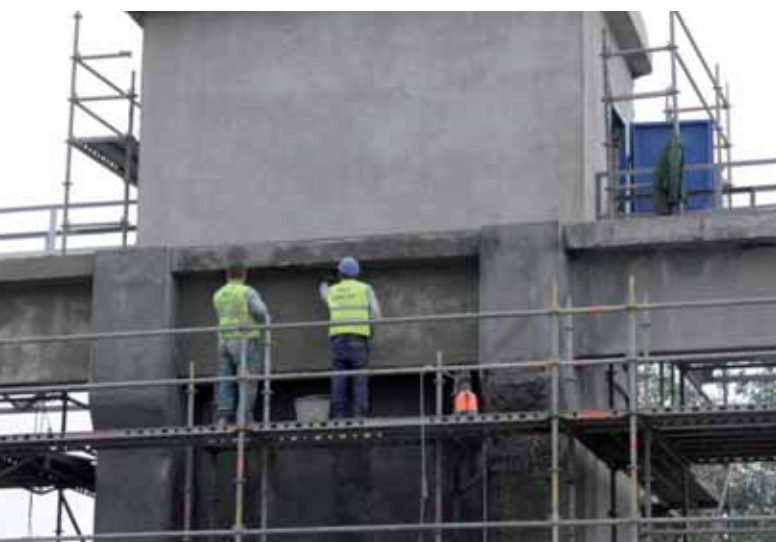
Prowadzone prace naprawcze konstrukcji w strefie zrzutu żużla z zastosowaniem tiksotropowej zaprawy naprawczej MAPEGROUT 430 (dawniej PLANITOP 430).
