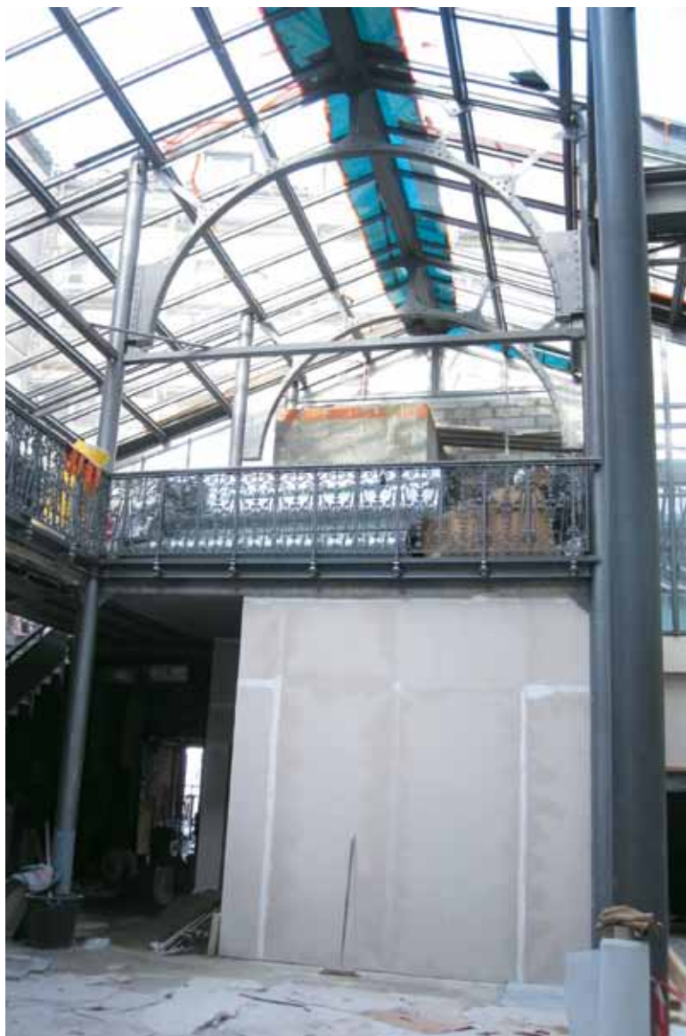
La verrière de la salle de réception pendant les travaux
