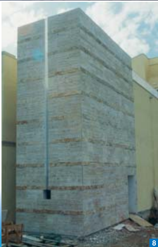
Foto 8. Anche le strutture esterne sono state rivestite con lastre in travertino levigato, posate con Kerabond+Isolastic e fugate con Keracolor FF.
