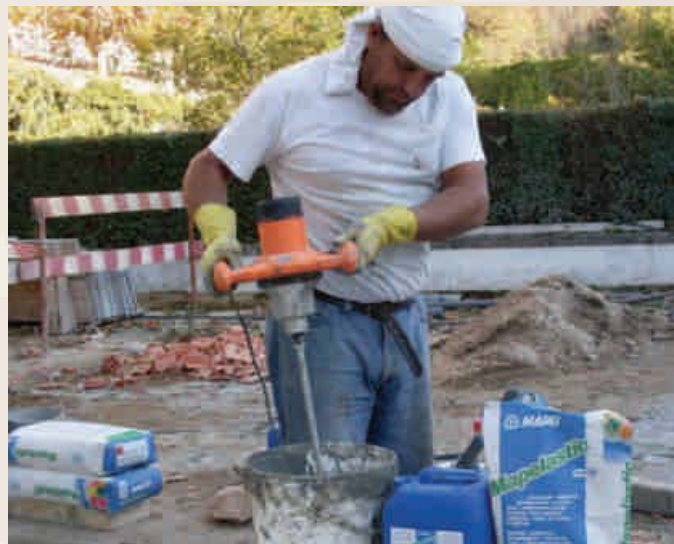
Preparação de argamassa cimentícia bicomponente MAPELASTIC
