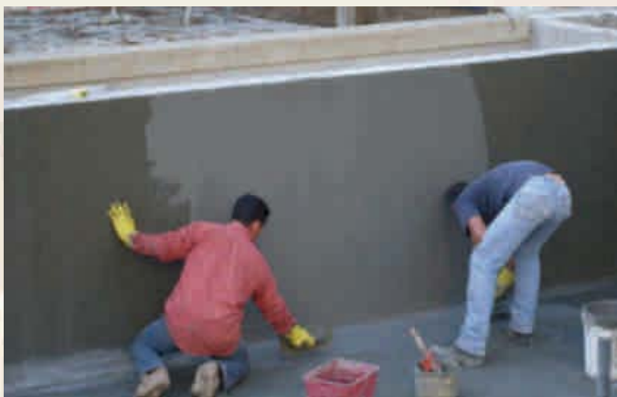
Aplicação do MAPELASTIC na piscina
