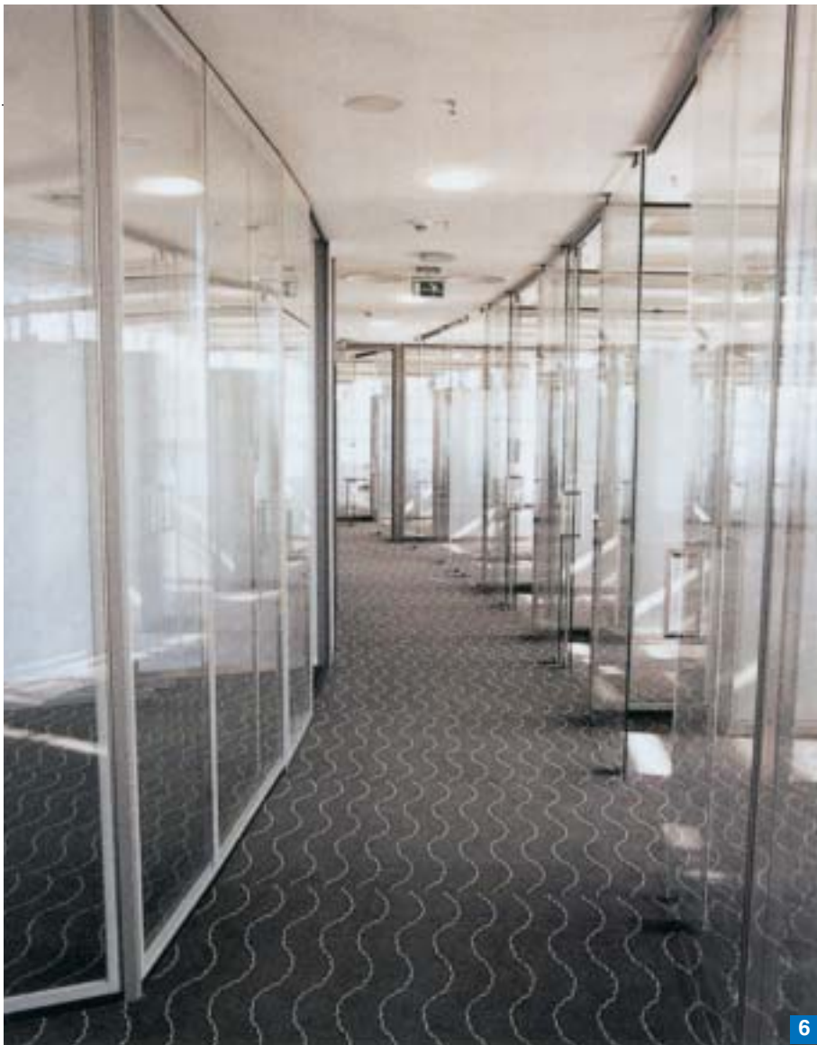
Foto 3. A causa dell'eccezionale geometria dell'edificio e delle rigorosissime esigenze tecniche, già la posa del pavimento sopraelevato ha richiesto un lavoro di precisione.
