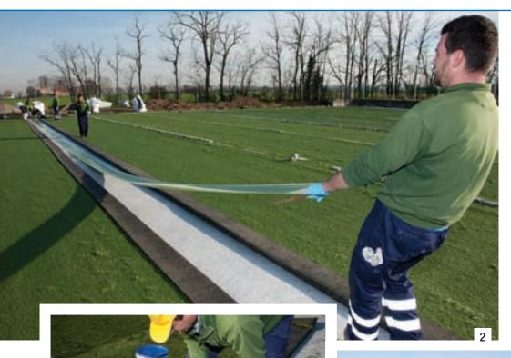
micron, tessitura tufted con 10.880 punti al m², ancorato su primario spalmato sul lato inferiore con lattice speciale resistente all'acqua, imputrescibile, drenante.
