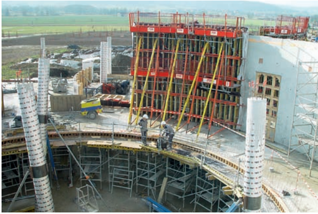
▲ Vue du coffrage d'une voile courbe
