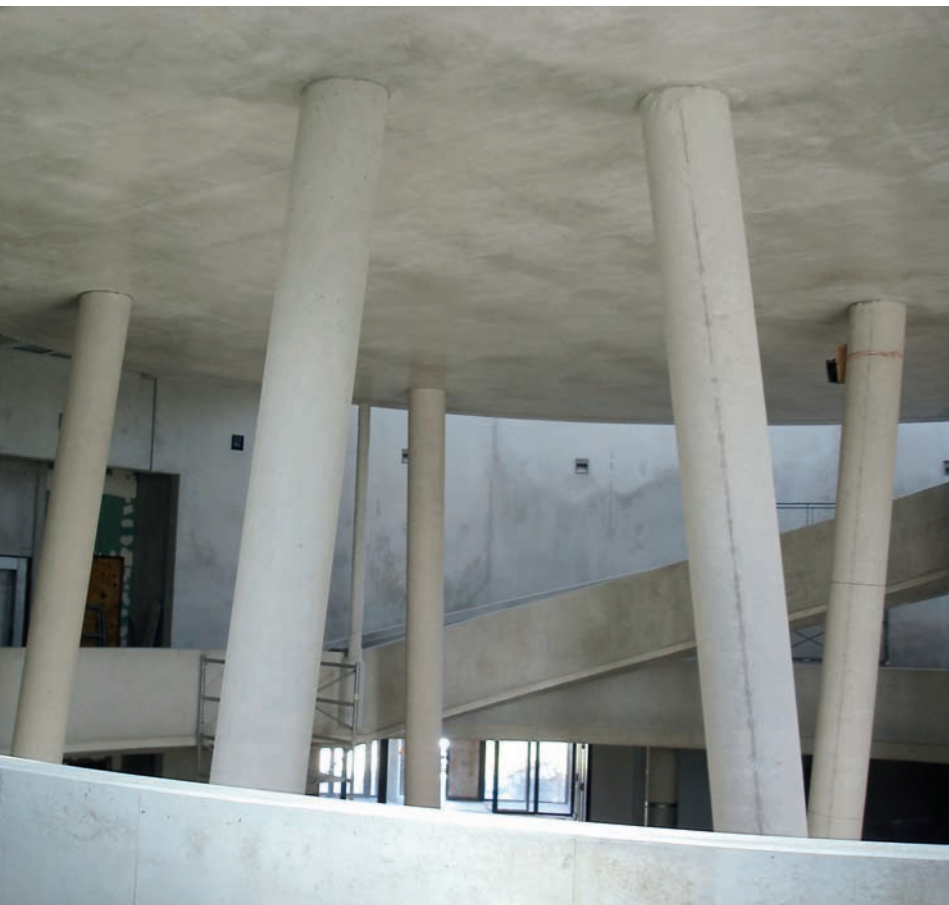
▲ Les 9 poteaux obliques soutiennent une dalle de 200 tonnes
