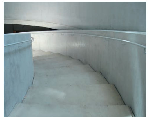
▲ Vue de l'escalier central
