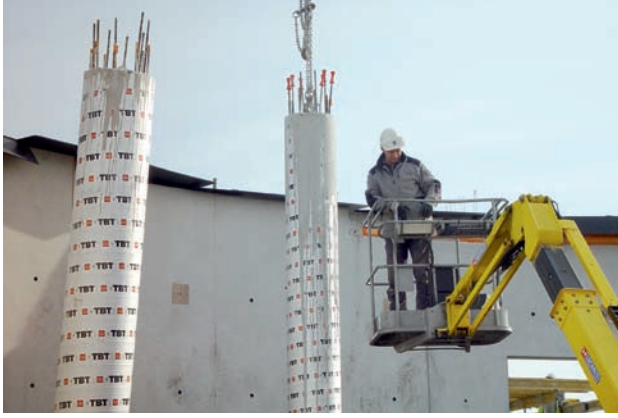
▲ Le coulage des poteaux de 8m30 de hauteur
