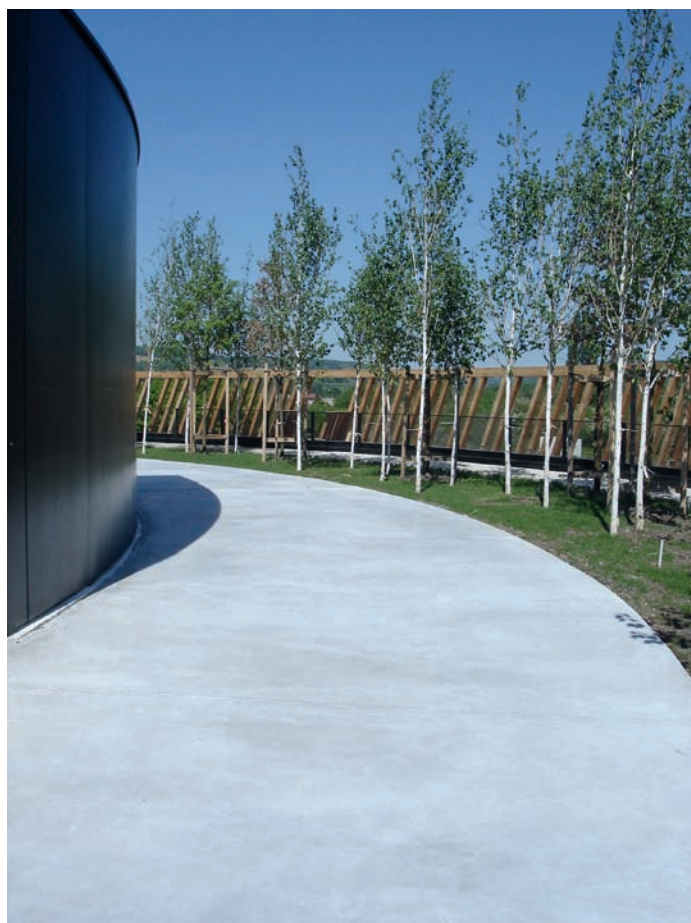
▲ Vue de la terrasse : la dalle au sol est restée brute mais les murs extérieurs ont été lasurés noir
