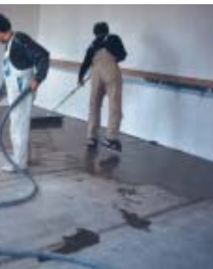
Foto 7: Das Ergebnis dieser gewissenhaft vorbereiteten und ausgeführten Arbeiten war eine ebene und glatte, für die Verlegung geeignete Oberfläche.
