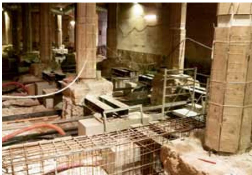
▼ Les fers HEB après vérinage
