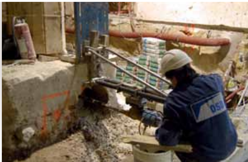
▲ Le perçement d'un massif existant avant la mise en place d'un HEB
