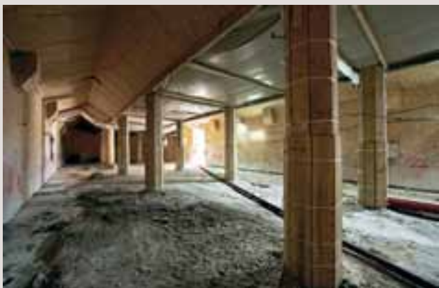
▼ Les 16 poteaux Louis XIII avant les travaux.
