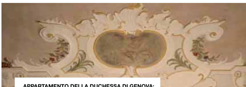
APPARTAMENTO DELLA DUCHESSA DI GENOVA: particolare della volta, dopo il restauro.
