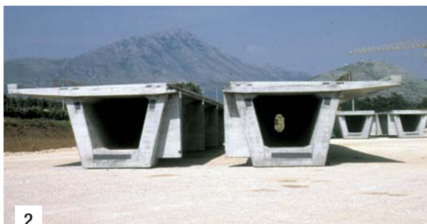
Foto 1. Visione d'insieme di uno dei viadotti della linea AV Roma- Napoli. Foto 2. Travi monocassone utilizzate sulla Roma-Napoli.
